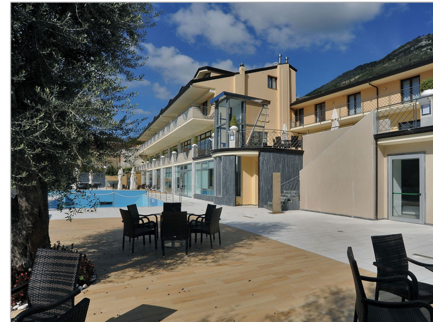
Trattamento protettivo idrorepellente con SCUDO. Non altera l'aspetto originario del materiale e previene tutti i fenomeni di infiltrazione di umidità che ne causano il degrado.
