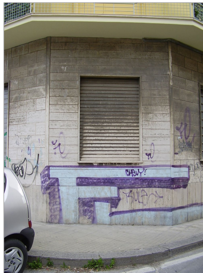
LUCCA, EDIFICIO PRIVATO Pareti in travertino
